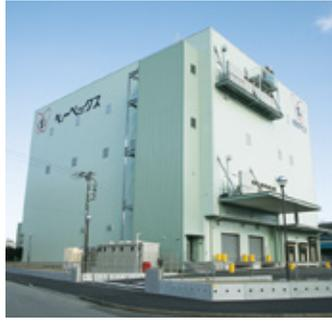
2019年に新設した5温度帯倉庫（冷凍・冷蔵・冷温・定温・常温）。免振構造で強固な保管環境
